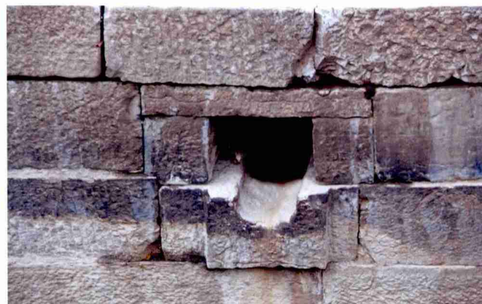
6.清代排水沟出水口(西-东)
